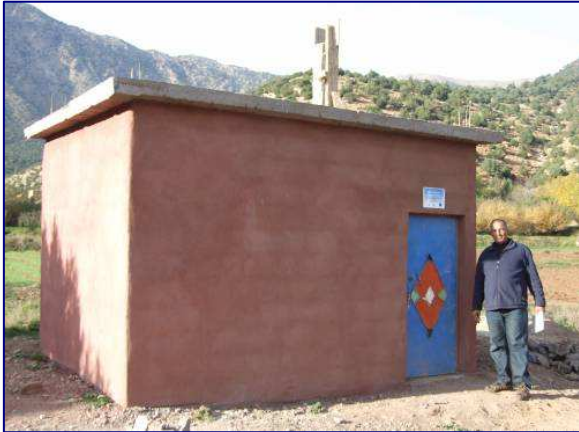
Local technique protégeant le forage
